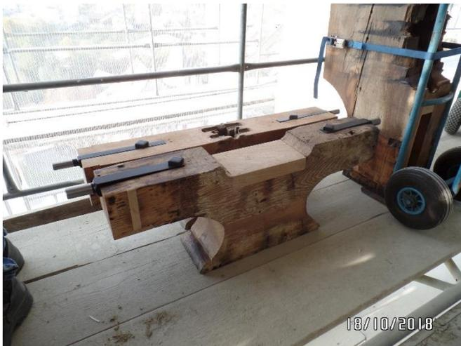
Les imposants jougs en chêne sont déposés, soigneusement restaurés et remis sur leur axe de rotation à paliers
